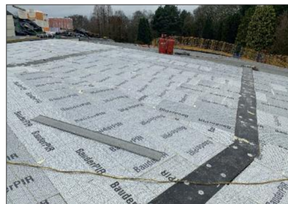
Verlegte Wärmedämmung aus BauderPIR.
