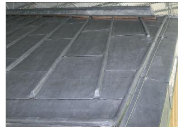
Bei großformatigen Bleiflächen zeigt die Falztechnik ihre Stärke: Die ausdehnungsfähigen Verbindungen lassen das Material arbeiten und gewährleisten stabile, sauber gegliederte Dachflächen über viele Jahre.
