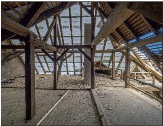
Der Dachraum vor der Sanierung.
